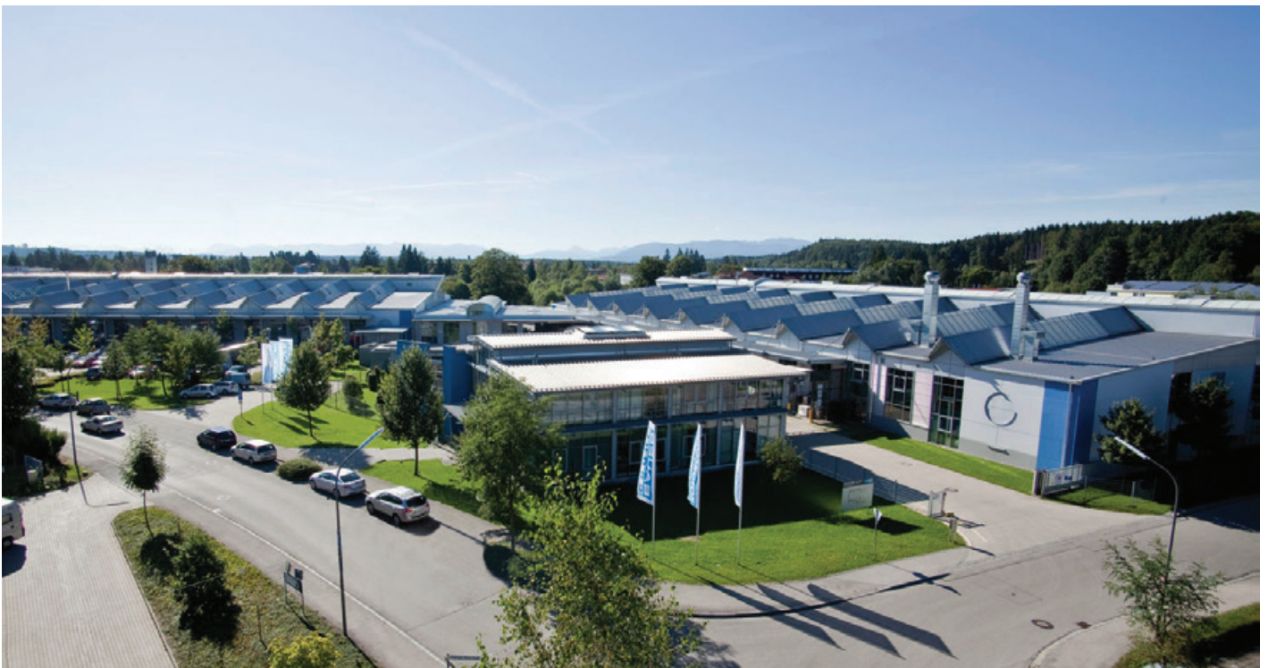
Usine I de BAUER KOMPRESSOREN – Geretsried, Allemagne
