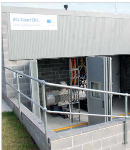
Leistungsstarke BK 52 Blöcke versorgen den öffentlichen Nahverkehr von Sydney mit CNG.
